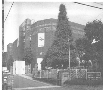
一期工事立ち上げ(10月)
