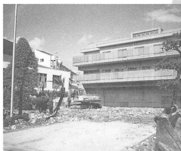
玄関 管理棟解体(7月)
